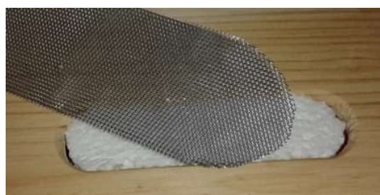
Obrázek 25 otvory k uchopení lze upravit jako větrací otvory
